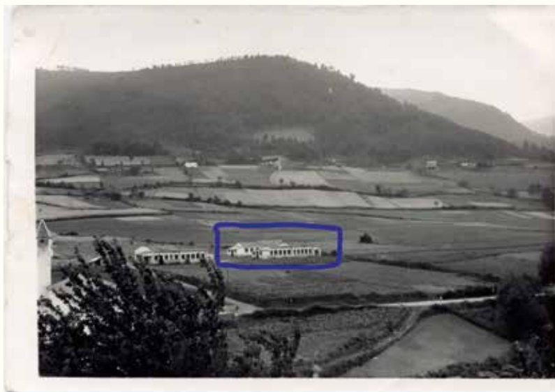
A Pontenova: Las construcciones señaladas en el recuadro se aprovecharon para convertirlas en sede de la Sección de Instituto de Formación Profesional
