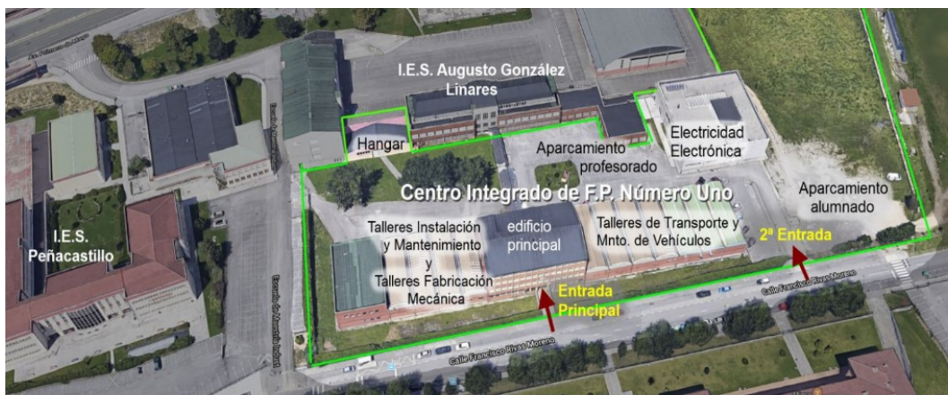
CIFPNº1, vista aérea SE
