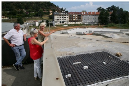
La consejera durante su visita a las obras. FOTO: Nacho Romero
